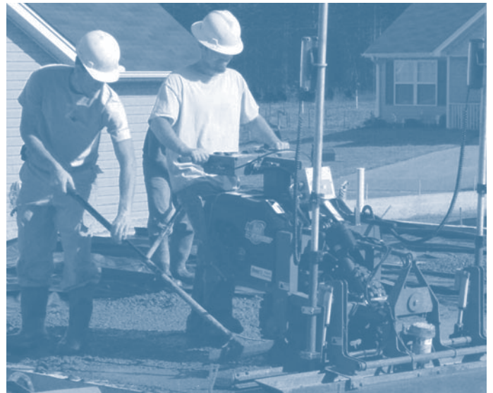
Der Somero® Mini Screed™ ist ideal für die Glättung von ebenerdigen Betonplatten in Wohnbereichen und im kleinen Umfang auch im gewerblichen Bereich.
